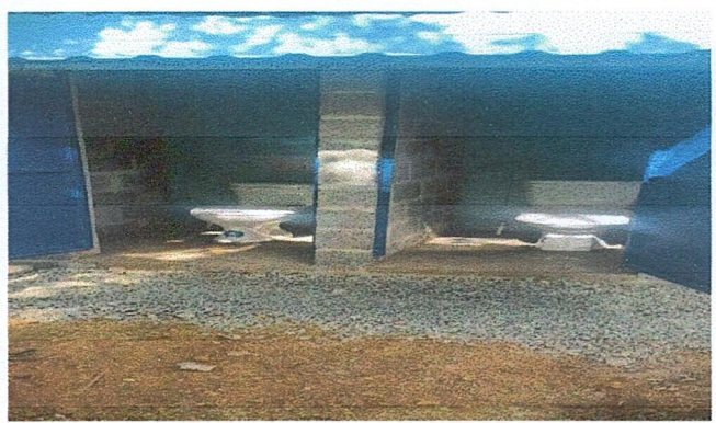
Foto 2: MEJORAMIENTO Y AMPLIACION DE SERVICIOS SANITARIOS
