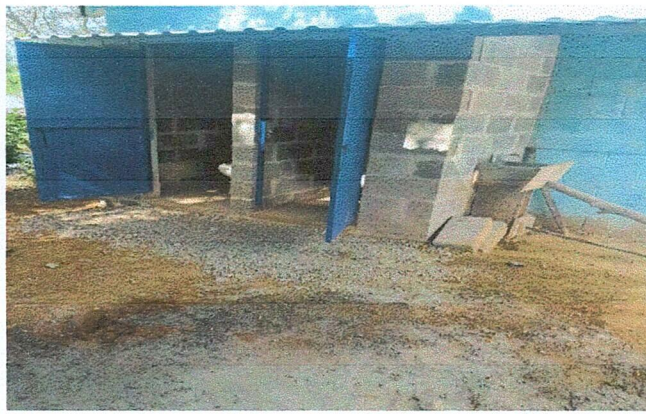
Foto 3: MEJORAMIENTO Y AMPLIACION DE SERVICIOS SANITARIOS
