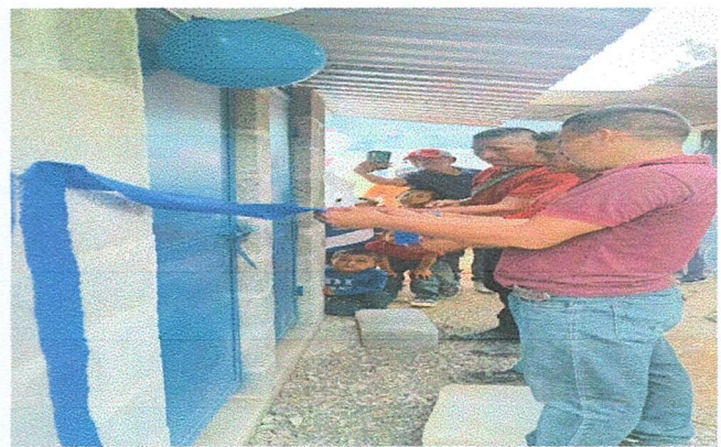
Foto 4: Reparación o sustitución de area de cocina.
