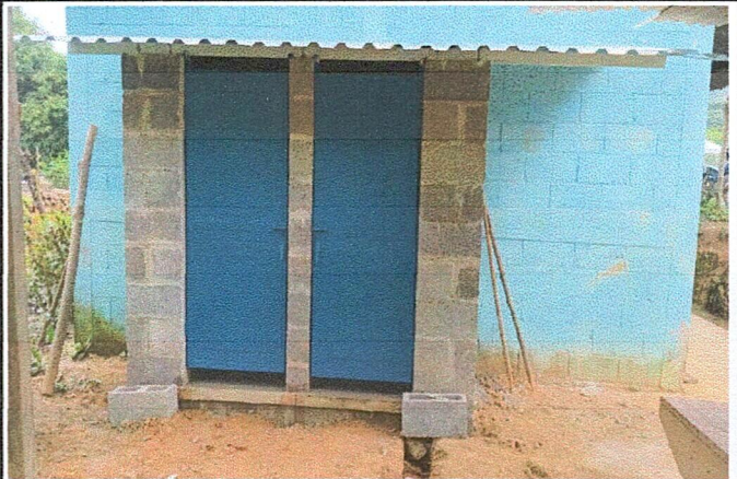
Foto 4: MEJORAMIENTO Y AMPLIACION DE SERVICIOS SANITARIOS
