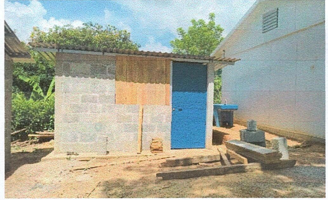
Foto 2: MEJORAMIENTO Y AMPLIACION DE ESTRUCTURA DE LAVAMANOS.
