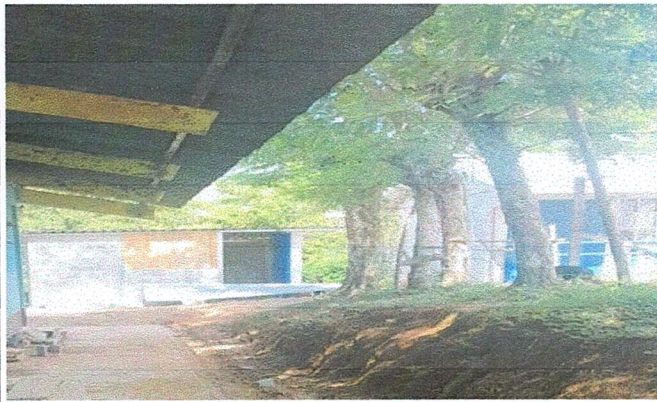
Foto 1: MEJORAMIENTO Y AMPLIACION DE ESTRUCTURA DE LAVAMANOS.
